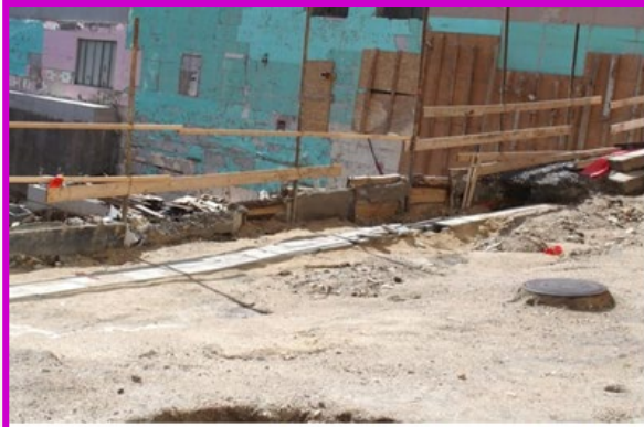
Propad vozovky v ulici Kopečná.
