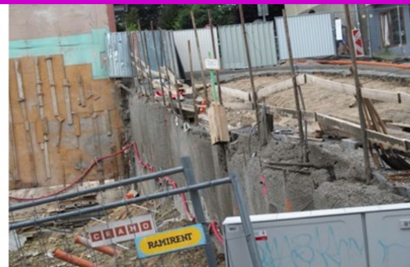
Destrukce opěrné stěny v severní části základové jámy.
